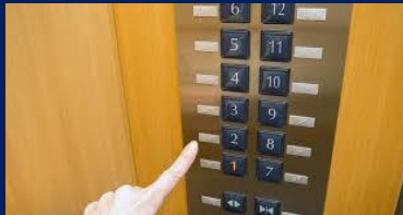
エレベーター
